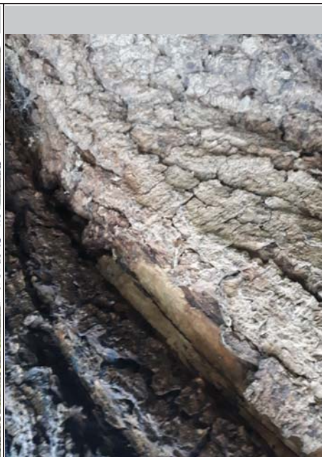
fissure longitudinale sur le tronc (nord)
