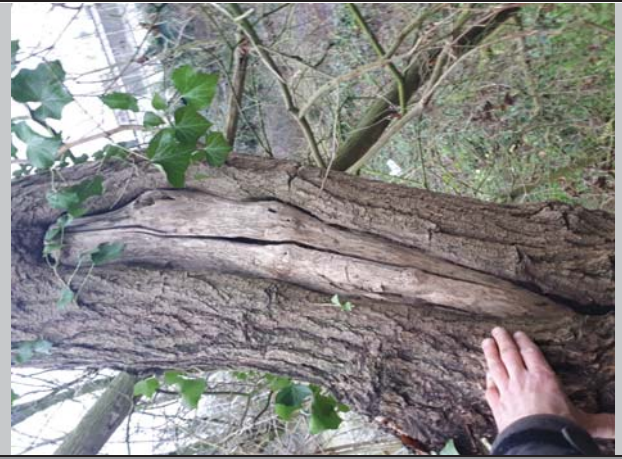
nécrose + fissure sur branche charpentière
