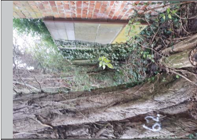
vue du pied : grande proximité bâtiment voisin
