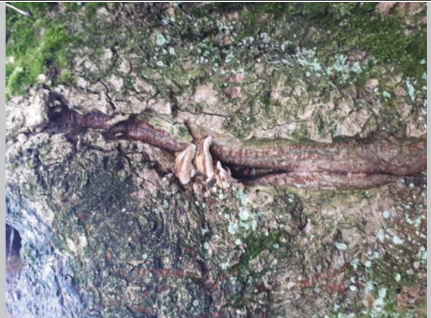
détail tronc : développement de champignons sur fissure
