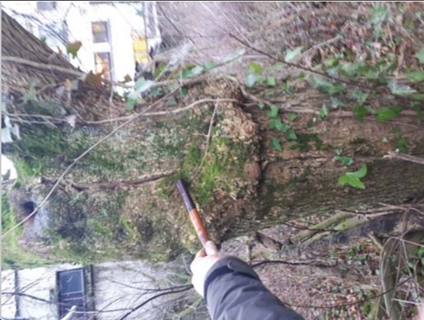
tronc : fissure longitudinale
